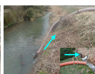
仮設ポンプ設置(珠洲市)
