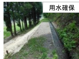
災害復旧事業で復旧
