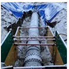
災害復旧事業で復旧
