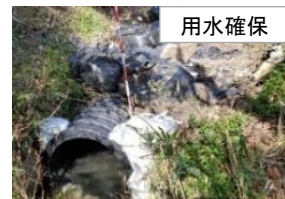
災害復旧事業の査定前着工による応急工事
