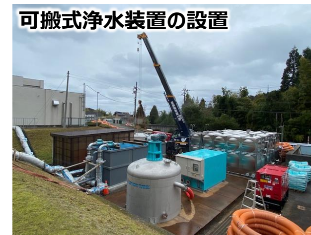
宝立浄水場可搬式浄水装置
