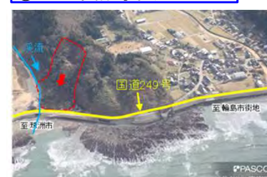
わじまし しぶたまち ⑧石川県輪島市渋田町
