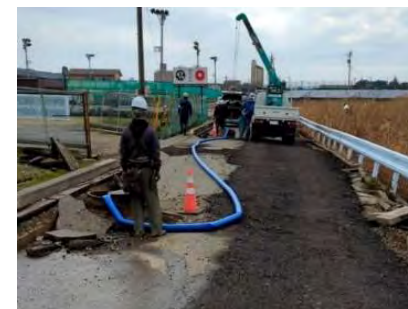
七尾市 バイパス管により下流のマンホールに送水
