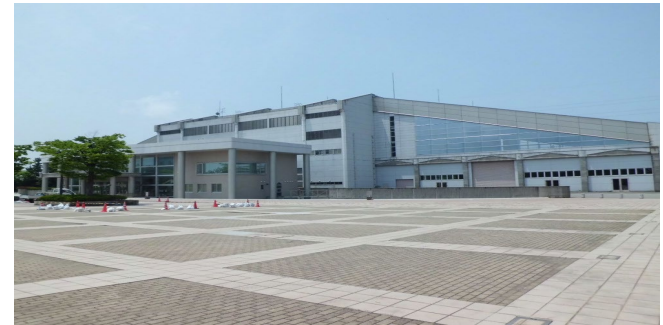
産業展示館4号館 外観
