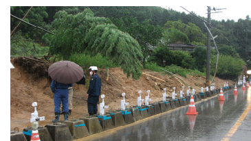
管内の危険箇所の警戒（福岡）
