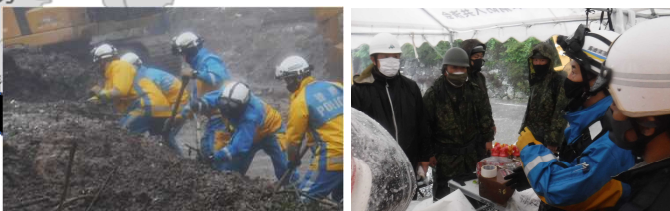
土砂崩れ現場での捜索活動（長崎）
