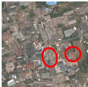
<平成28年熊本地震 被災後（2016年4月16日撮影）>
