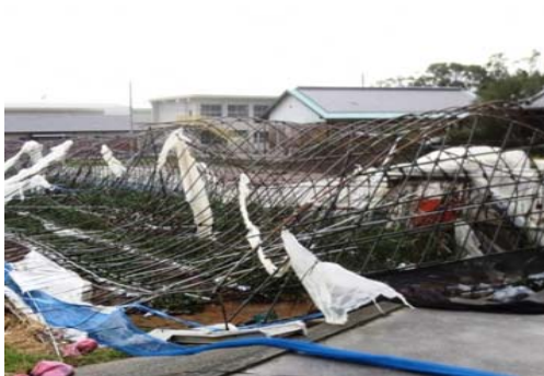
台風によるハウスの倒壊
