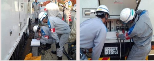
（電源車による電源の復旧・通電）
