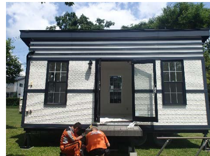
トレーラーハウス
