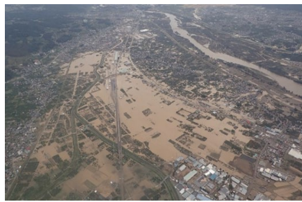
令和元年東日本台風 千曲川堤防決壊による浸水状況（長野県長野市） （長野県ウェブサイトより）
