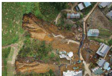
令和元年東日本台風 地すべりによる被災状況 (群馬県富岡市)
