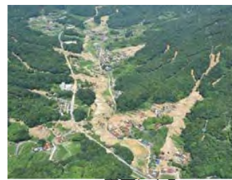
H30.7豪雨による 広島県呉市安浦町周辺の被災状況
