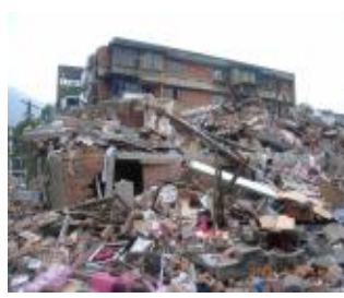
四川大地震で倒壊した建物 (中国四川省・都江堰市)
