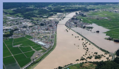
山形県大石田町最上川沿川の浸水状況
