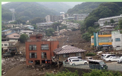
静岡県熱海市における土石流の被害状況
