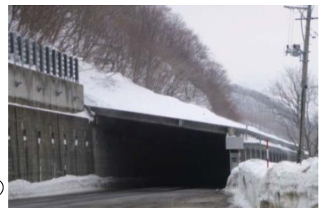
スノーシェッド(道路に屋根を設けた雪崩対策施設)
