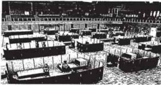
益城町避難所。避難者約500人（25日）
