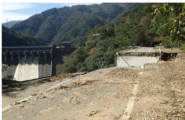
国道327号崩落現場視察 【諸塚村七ツ山】
