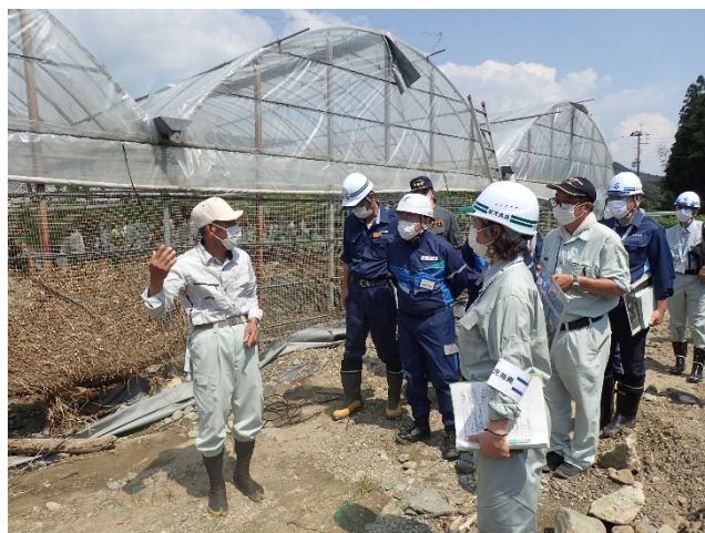
被災現場確認 【薩摩川内市東郷町山田】
