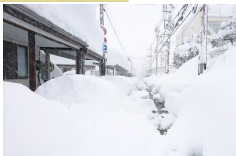
消雪パイプによる散水が機能しない状況
