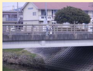
②曼荼羅橋の危機管理型 水位計を車内から確認
