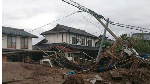
令和元年東日本台風の被害（長野県の土砂災害）
