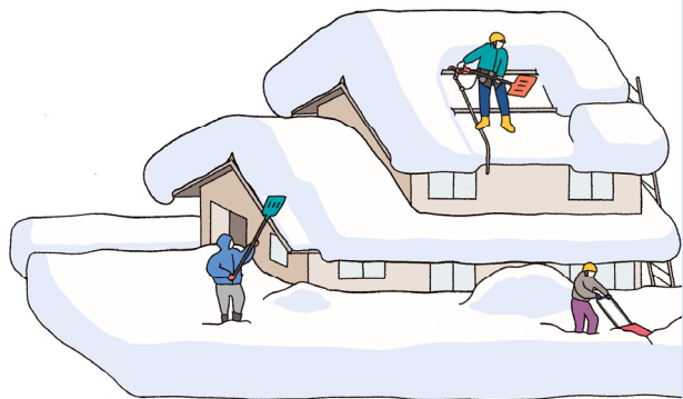
住宅が倒壊しないよう 屋根雪の雪下ろし
