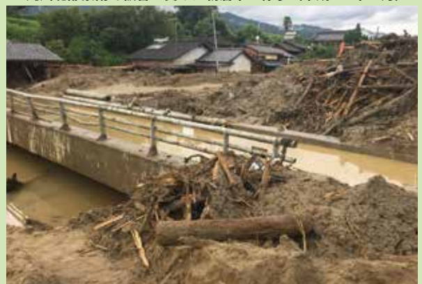
九州北部豪雨で被害を受けた朝倉市の様子（平成 29 年 7 月）
