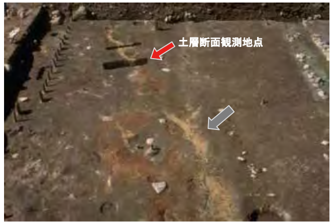
液状化跡 (南東)
