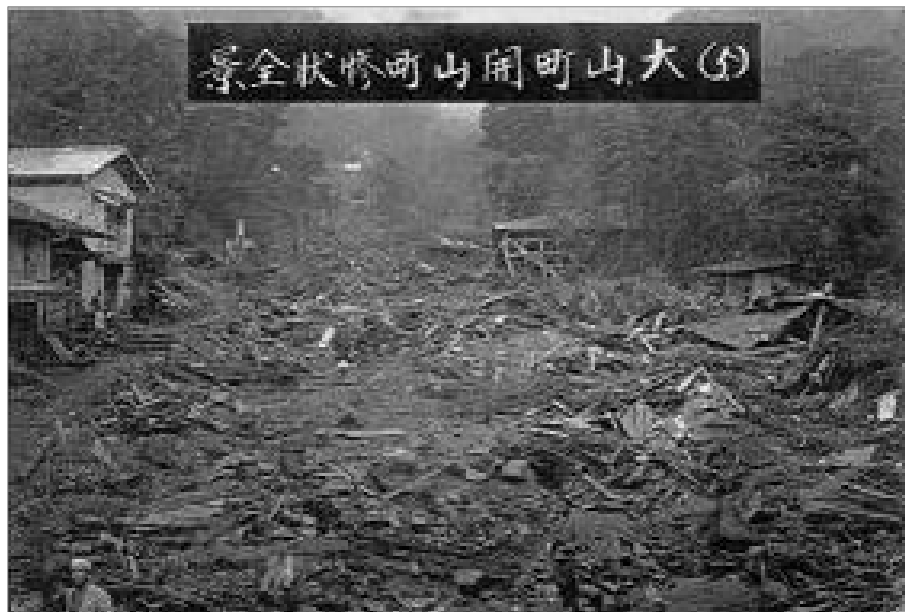
写真 3-1-2 神奈川県中郡大山町(現伊勢原市内)で 9月15日に発生した土石流災害(伊勢原市議会事務局蔵)
