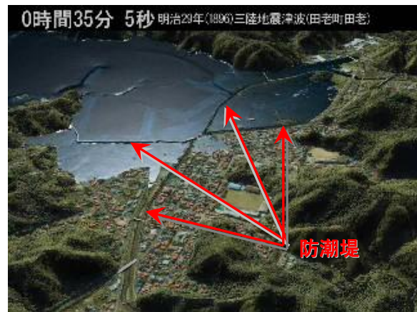
図 6-5 明治三陸地震津波が今の田老町に来たら…（岩手県ホームページのCG画像。画面左上に到達した津波が、短い時間のうちに防潮堤を越えて陸地に入ってくる様子が公開されている）
