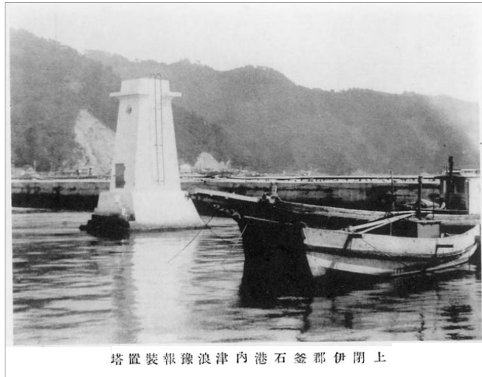
写真 4-5 釜石港に設置された津波予報塔 (岩手県土木課『震浪災害土木誌』1936年)
