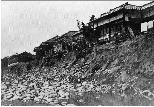
写真 1-5 流失寸前で難を逃れた新川 橋上左岸沿いの住宅（巴町） （出典：写真 1-3 に同じ）
