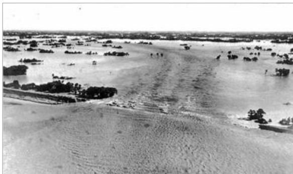
写真 1-7 利根川右岸埼玉県東村での 越水・決壊 （国土交通省利根川上流河川事務所蔵）
