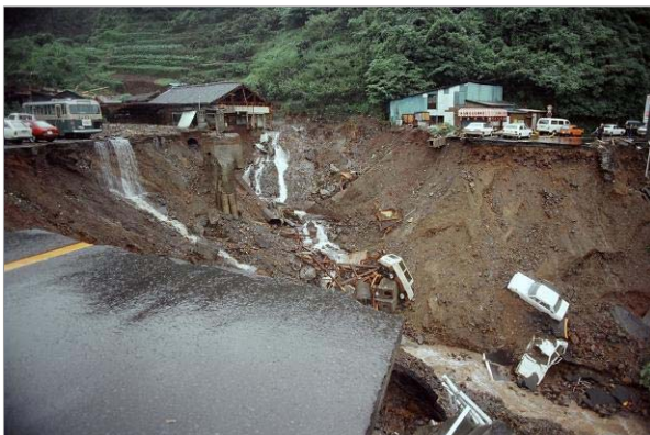
写真 3-4 国道 34 号芒塚の道路流失現場 (出典：写真 3-2 に同じ)
