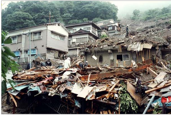
写真 3-2 鳴滝町の土砂崩れ現場。24 人が被災(長崎の写真映像プロダクション DEITz(株)提供)
