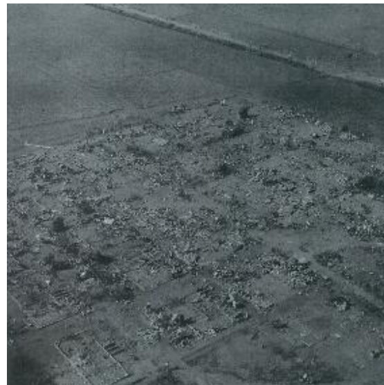
写真2-4 堤防の寸断によって高潮氾濫の直撃を受け、跡形もなく流失した半田市の住宅(出典:写真2-3に同じ)
