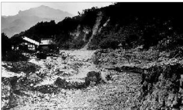
写真 1-1 昭和 22 年カスリーン台風による 沼尾川の被害（群馬県旧赤城村深山） （敷島村役場『沼尾川流域災害記録』昭和 22 年 9 月より ※敷島村：現渋川市）
