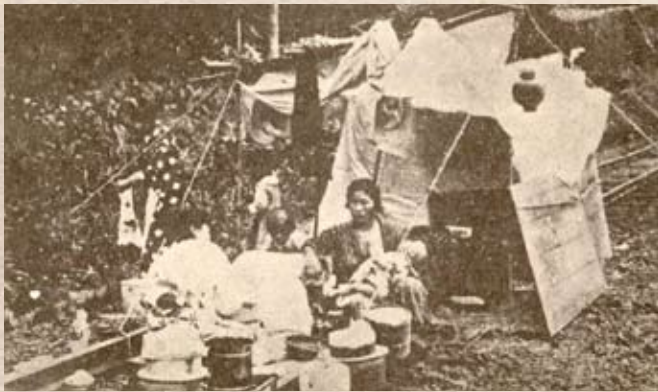
線路上に避難して仮小屋を構えた被災者
