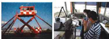
非常用管制塔外観
