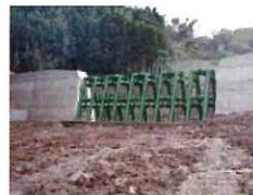
流木捕捉式治山ダム
