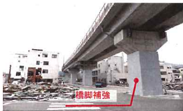
東日本大震災における橋梁の状況（耐震対策完了済み）
