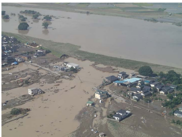
堤防決壊により浸水した住家の様子 【茨城県常総市内】
