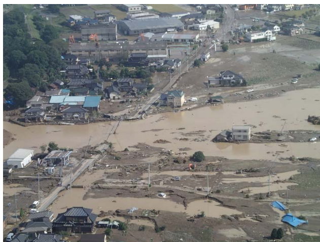
泥流により被災した道路、住家の様子 【茨城県常総市内】
