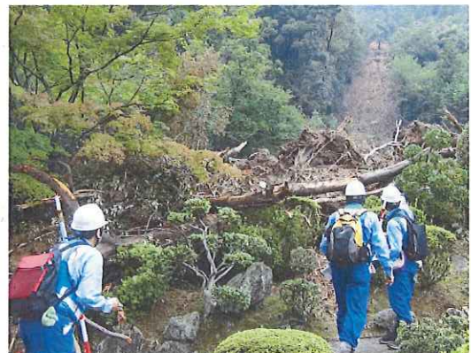
テックフォースによる点検状況
