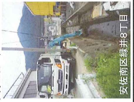
③八木用水の土砂撤去
