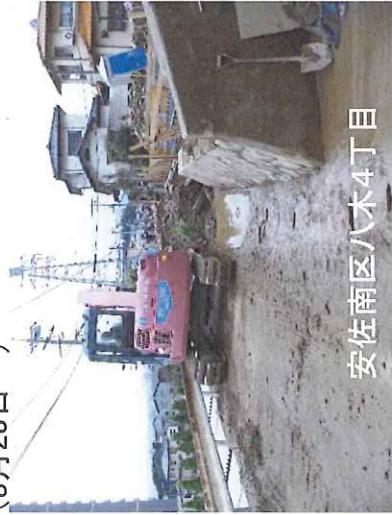
①土石流対策に必要な道路の土砂撤去
