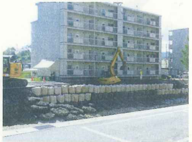
被害を受けた苔川護岸の応急復旧の様子 【高山市西之一色町】
