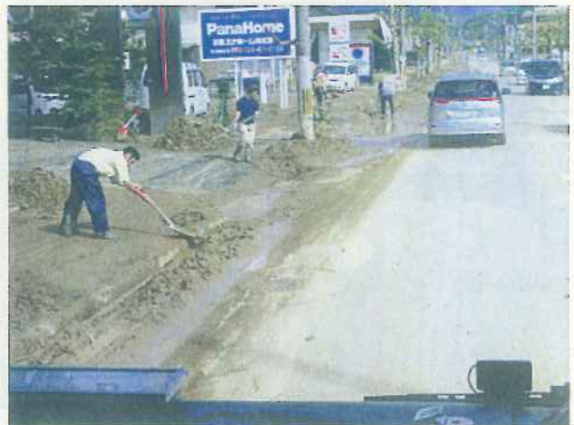
泥土に覆われた道路の後片付けの様子【京都府福知山市内】
