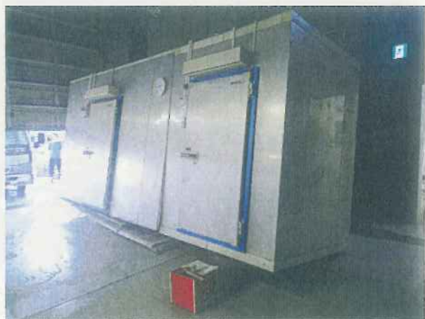
浸水被害を受けた地方卸売市場の冷蔵庫 【京都府福知山市問屋町地区】
