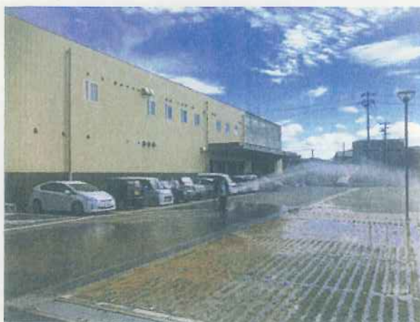
浸水被害を受けた学校給食センターの 復旧作業の様子【京都府福知山市問屋町地区】
