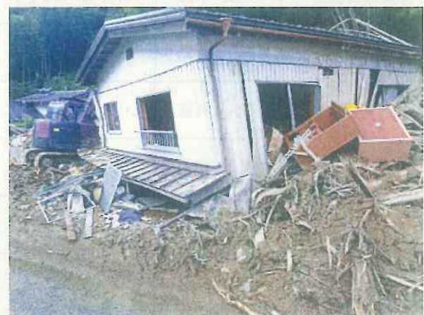
土砂災害の被害を受けた住宅の様子 【兵庫県丹波市市島町徳尾地区】
