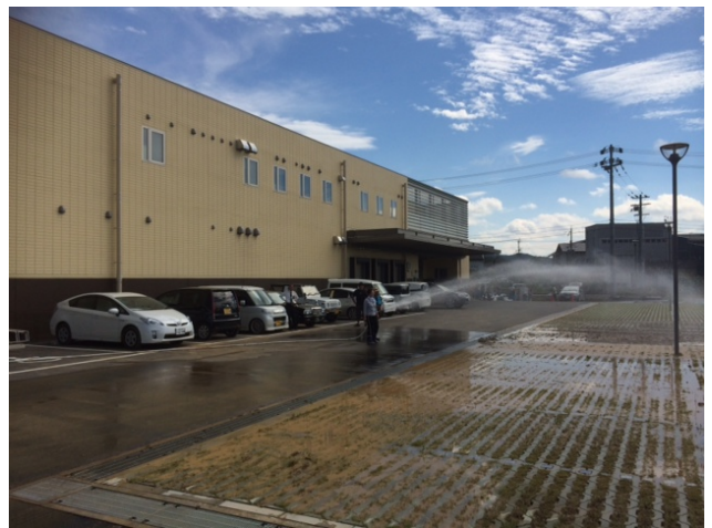
浸水被害を受けた学校給食センターの 復旧作業の様子【京都府福知山市問屋町地区】
