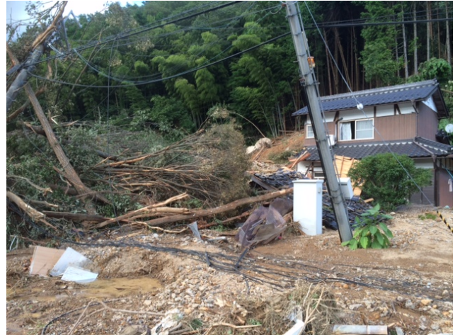
土砂災害の被害を受けた住宅の様子【兵庫県丹波市市島町徳尾地区】
