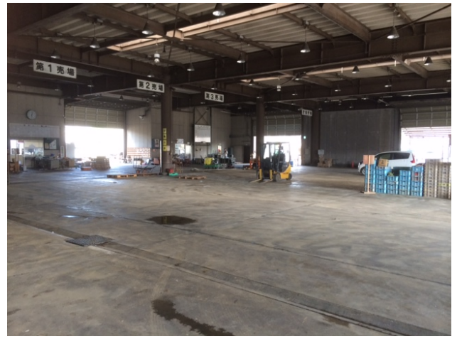
浸水被害を受けた地方卸売市場の様子 【京都府福知山市問屋町地区】
