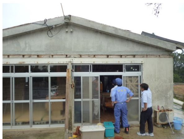
被害現場の状況を調査【立長地区】
