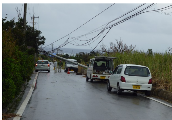
電柱倒壊の様子【麦屋東区地区】
