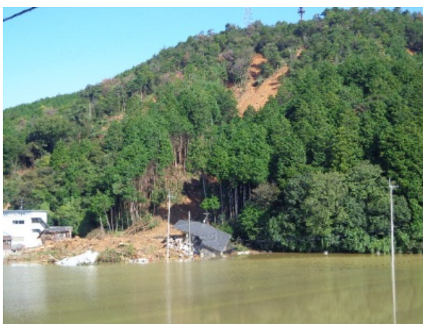
土砂崩れ、住家被害、冠水の様子【栗東市下戸山地区】
