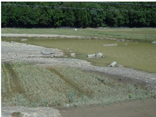
野木川の破堤による冠水の様子 【福井県三方上中郡若狭町下野木地区】
