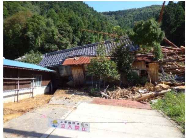
土石流による住家被害の様子 【福井県小浜市忠野地区】
