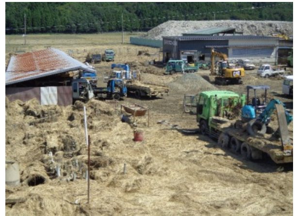
野木川の破堤により被害を受けた工場 【福井県三方上中郡若狭町下野木地区】
