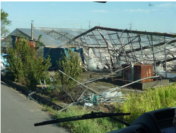
ビニールハウスの被害の様子 【熊谷市江南地区】
