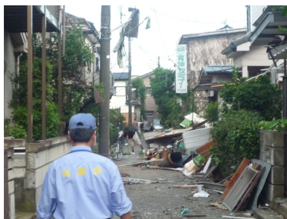
住宅街の被害の様子① 【埼玉県越谷市下間久里地区】
