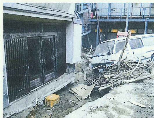
被害を受けた建物及び車両【岩手県盛岡市繫温泉】
