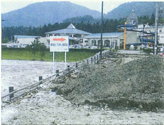
土砂流入の被害状況【岩手県紫波町ラ・フラン ス温泉】
