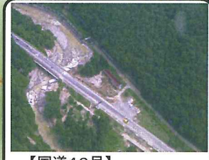
【国道46号】 道路一部損壊
