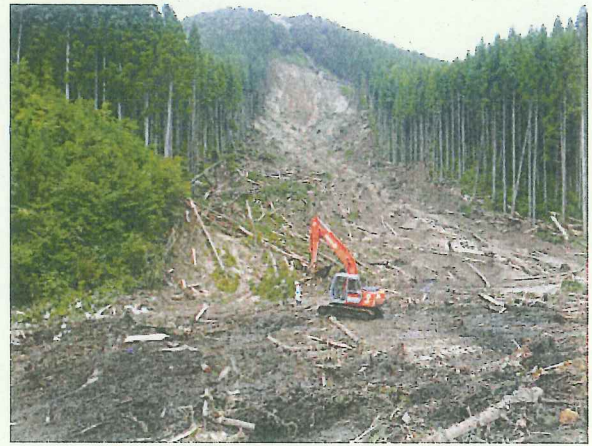
土石流による被害の様子①【同】
