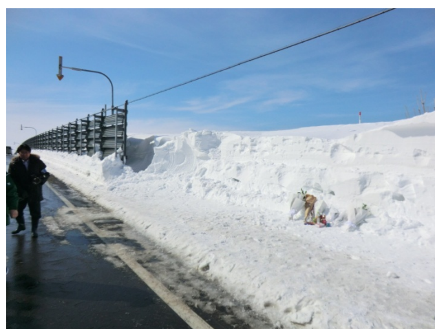
↑ 被害現場の状況【中標津町俵落】
