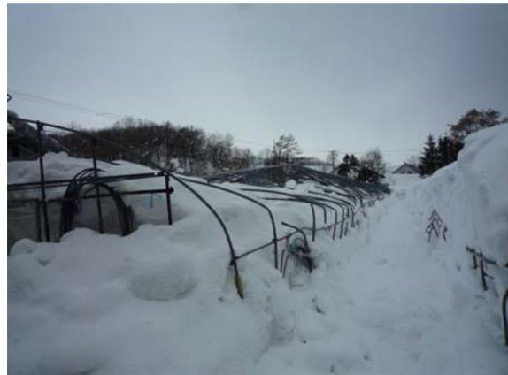
↑雪の重みで倒壊したパイプハウスの状況【三笠市】
