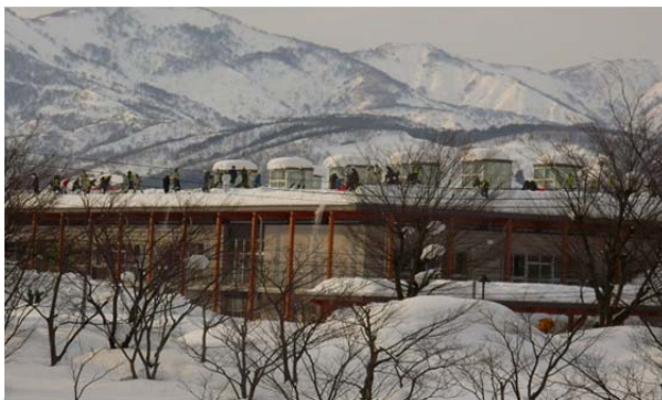
↑小学校の屋上における雪下ろし作業の状況（妙高市上町）
