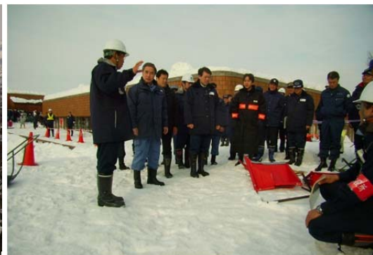
↑文化ホール屋上における雪下ろし作業を確認し、激励する大臣（妙高市上町）
