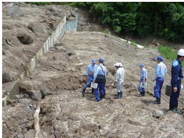
2号堰堤下流の土石流堆積状況調査
