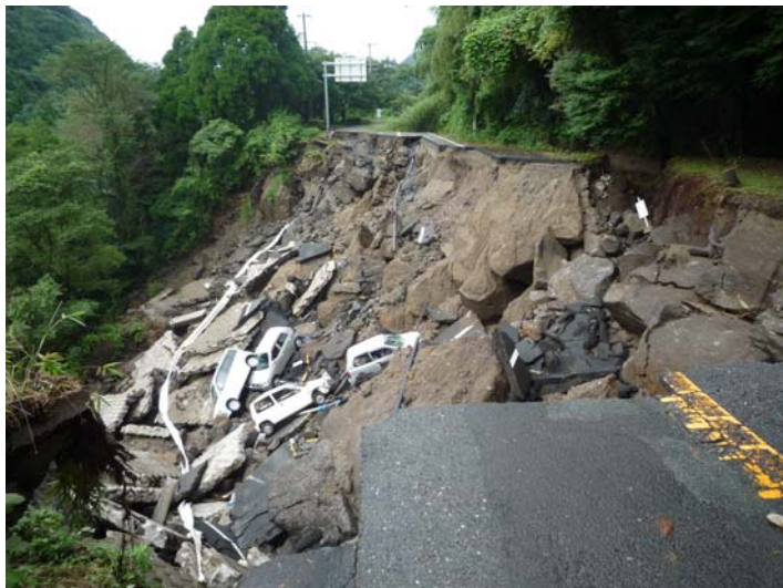
県道都城隼人線崩落の状況
