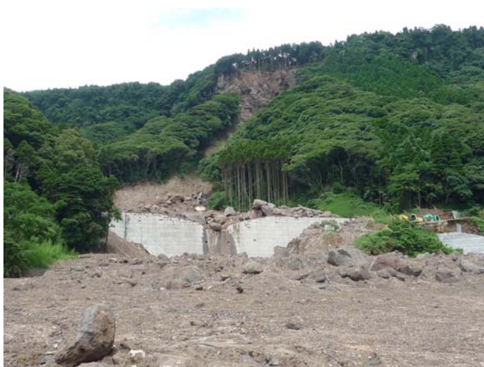
船石川土石流現場の状況
