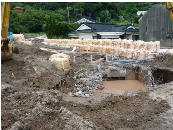
船石川下流の応急対策工事の状況
