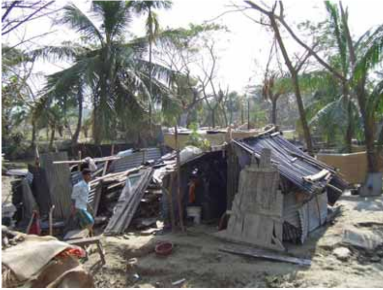
破壊された家（バルグナ Bishkhali 川の道路沿い）
