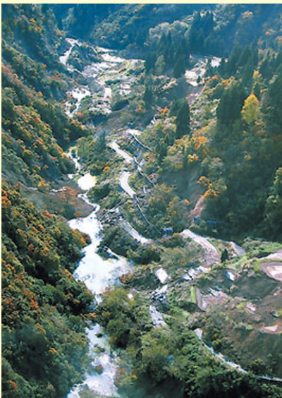
■国道291号の被災状況
