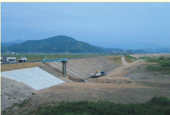
■修復され築堤された破堤箇所
