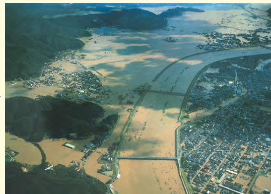
■台風第23号により被災した円山川流域 (平成16年10月)
