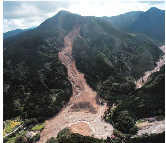
■現在も警戒体制が続く別府田野川流域（宮崎市内） 〔崩壊総量：約350万m 3 （東京ドーム3杯分相当）〕
