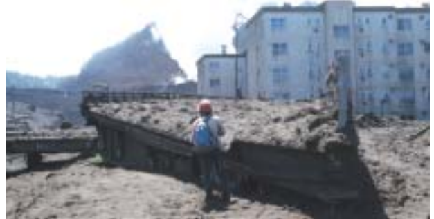
泥流に流された橋脚
