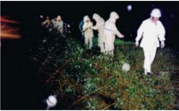
増水で洗掘された安倍川本堤防を、「木流し工法」で応急処置する静岡市水防団（9月10日 写真提供：静岡市防災課）
