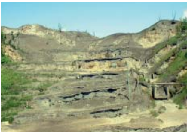
約70m隆起した道路
