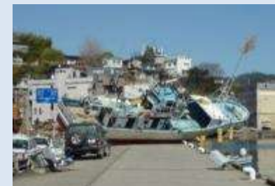
津波による被害（宮城県気仙沼市）
